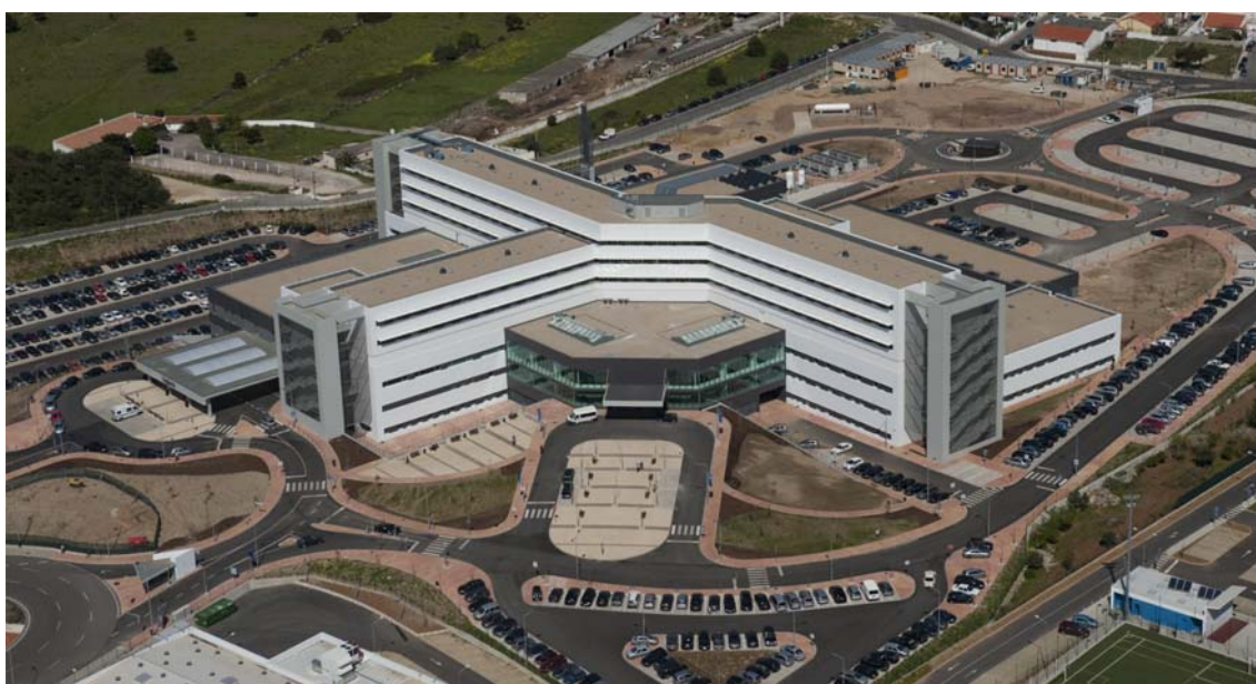
Figura 28 – Imagens do caso de estudo relativo a edifício hospitalar.
