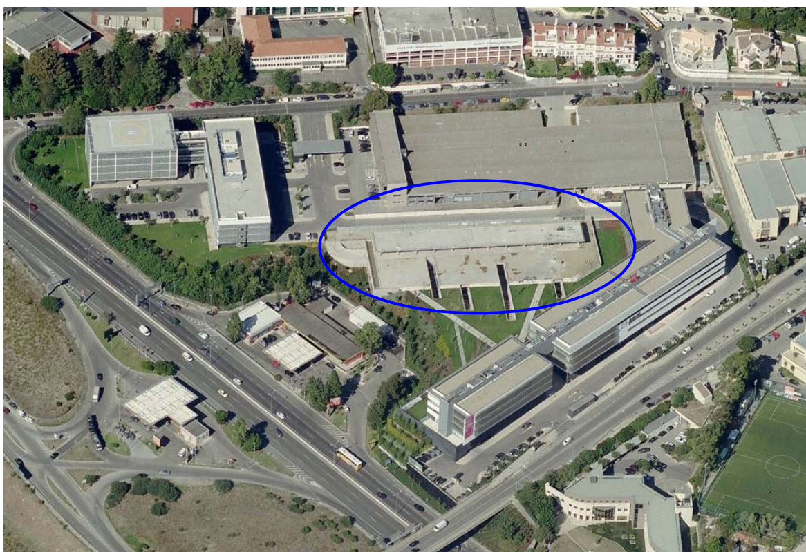
Figura 31 – Vista aérea do caso de estudo relativo a equipamento de lazer, edifício multiusos.
