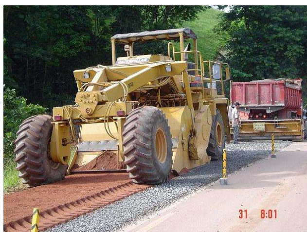
Fig. 17 – Reciclagem com mistura de agregados (Arrieiro, 2007)
