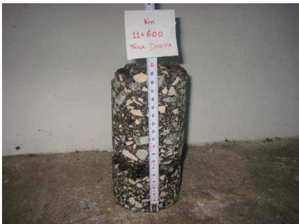
Fig. 58 – Marcas da descolagem entre camadas num tarolo extraído do pavimento existente (Araújo, et al , 2008)
