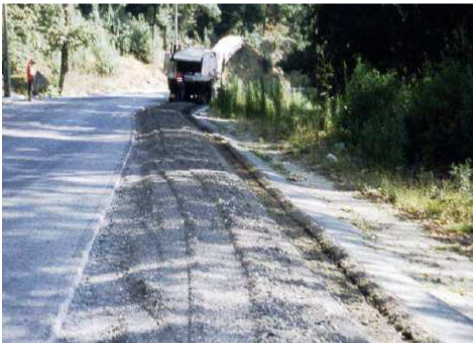
Fig. 40 – Trabalhos de fresagem antes da passagem da recicladora na EN108 (Batista, 2004)
