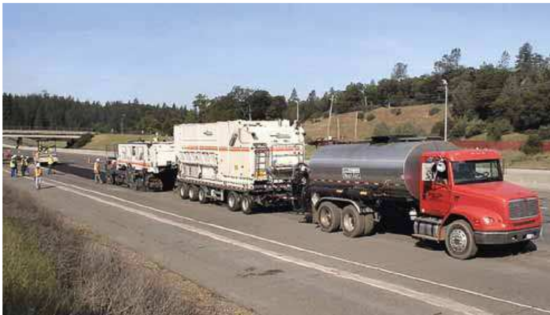
Fig. 31 – Comboio composto pela recicladora, misturadora e cisterna de emulsão (Wirtgen, 2005)
