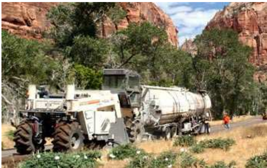
Fig. 24 – Reciclagem “ in situ ” a frio com a WR 2500 no Zion National Park, UT (FHWA, 2008)
