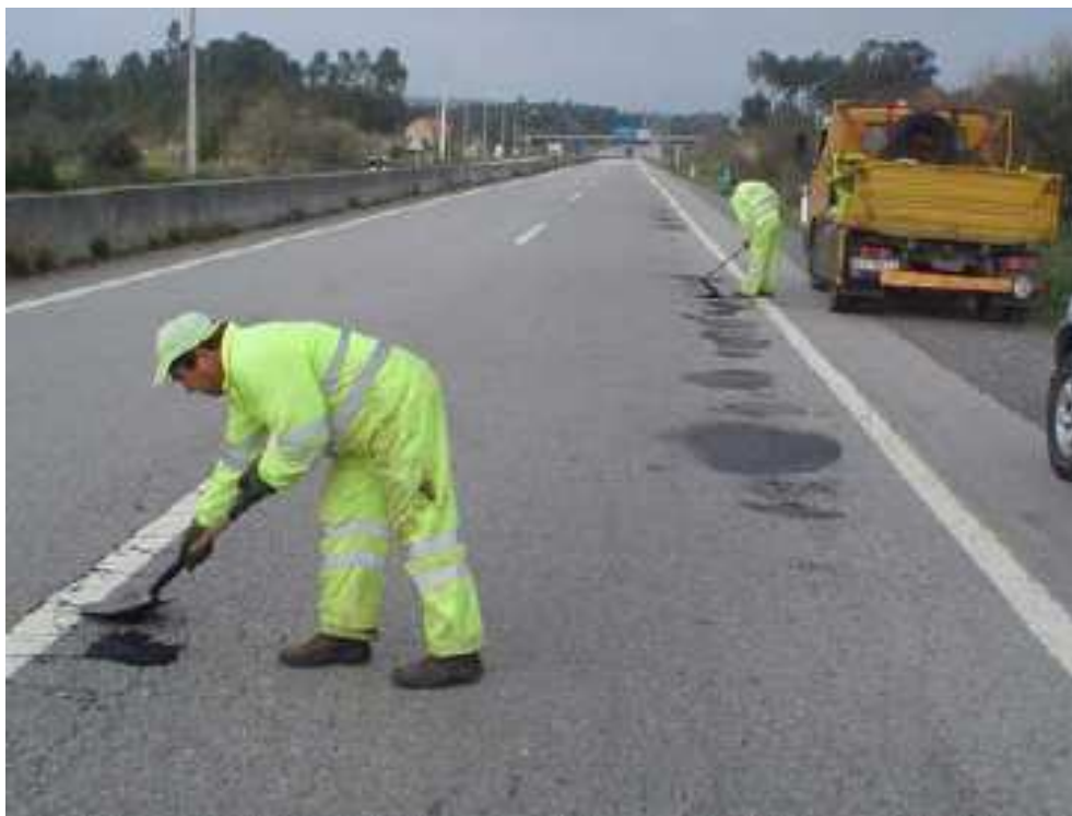
Fig. 59 – Tapagem das covas existentes na via da direita (Araújo et al. , 2008)
