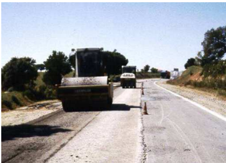
Fig. 44 – Compactação da camada reciclada na EN 260 (Batista, 2004)
