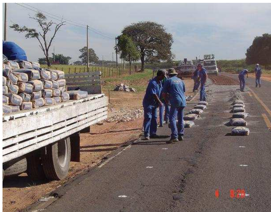
Fig. 19 – Espalhamento manual de cimento (Arrieiro, 2007)
