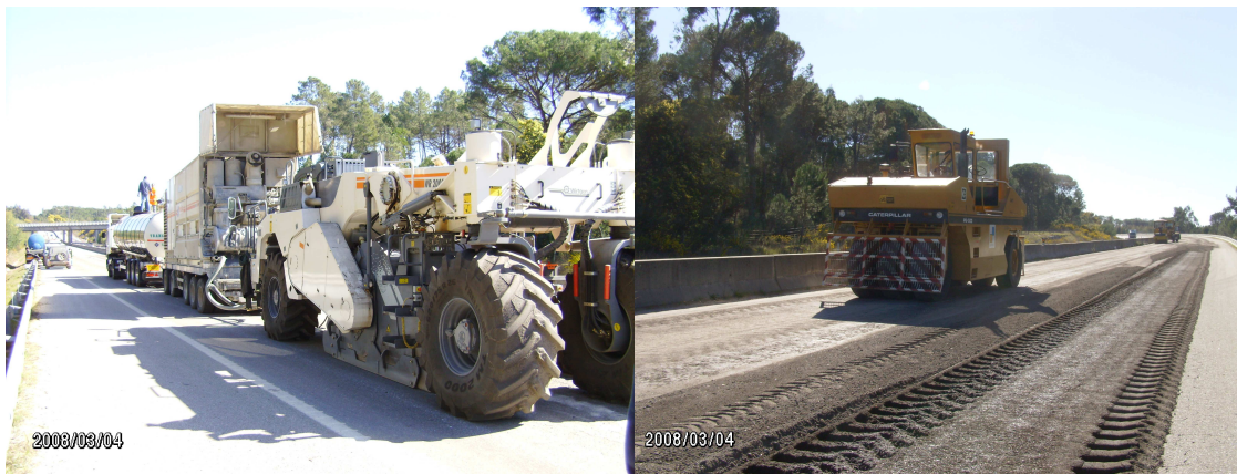
Fig. 62 – Imagens do “comboio” de reciclagem (à esquerda) e do cilindro pneumático em plena compactação (à direita) – IC12
