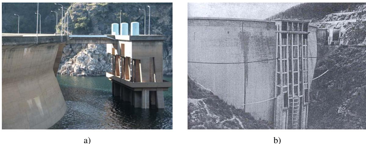
**Figura 5.3:** a) Vista lateral da barragem e da torre das tomadas de água com os órgãos de manobra das comportas. b) Vista do paramento de montante da barragem e da torre das tomadas de água [Xerez, 1954].
