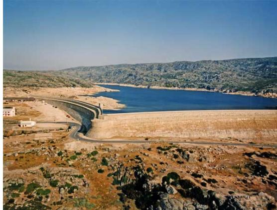
**Figura 2.3:** Barragem da Lagoa Comprida, Portugal (barragem de gravidade em alvenaria).
