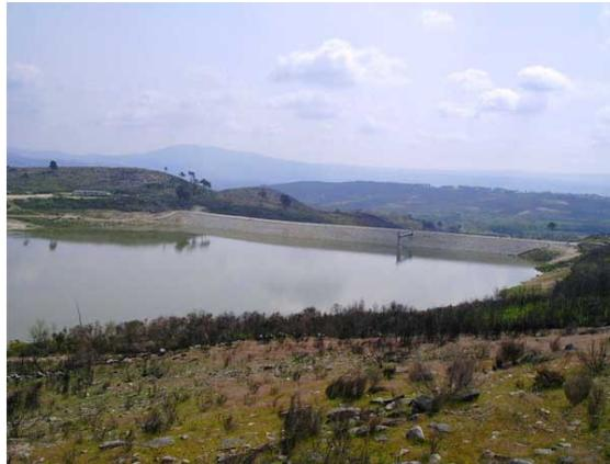
**Figura 2.4:** Barragem de Rego do Milho constituída por terras e enrocamento, Portugal.
