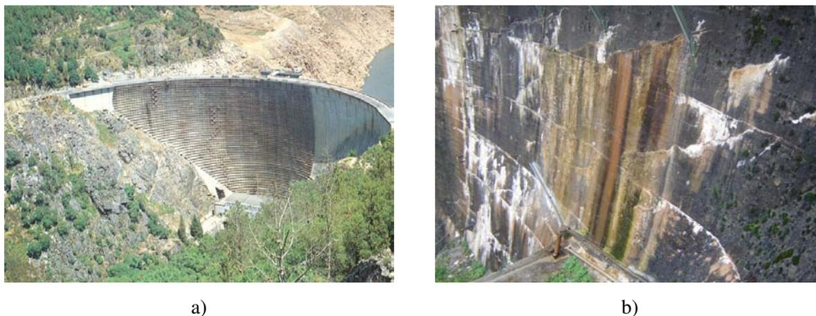
**Figura 2.7:** a) Trabalhos de reparação na barragem do Cabril que consistiram no tratamento da fundação, injeção das juntas de contracção e tratamento da fissuração significativa. b) Reacções álcali-agregado na barragem antiga do Alto Ceira.
