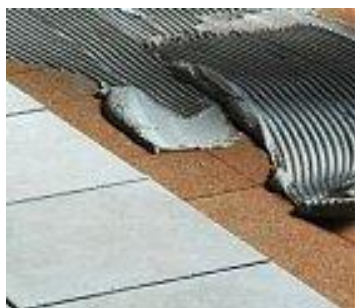
Figura 32 – Isolamento dos pisos [4]
