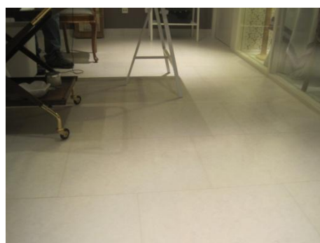
Figura 157 – Revestimento do Atelier
