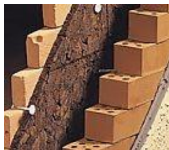
Figura 33 – Isolamento no interior das paredes [4]
