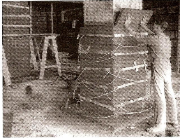
Figura 3 – Aplicação de aglomerado negro para o isolamento no edifício da Comissão Reguladora do Comércio do Bacalhau, em Lisboa [2]
