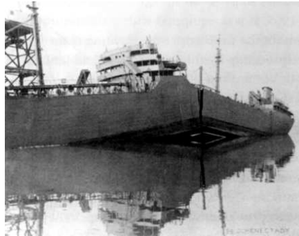
FIG. 5.1 – Le Schenectady, un paquebot militaire américain d'acier qui s'est spontanément coupé en deux lors de sa mise à l'eau.
