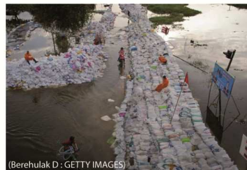
Fig. 8.9. Dispositifs de protection : batardeaux, sacs de sables.
