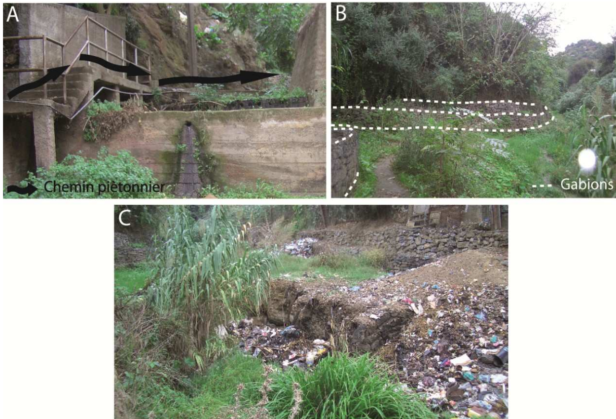
Fig. 7.27. Sous-bassin du Chemin du Fort (A). Chemin piéton (B). Système de gabionnage installé sur les berges (C). Décharge sauvage sur les versants.
