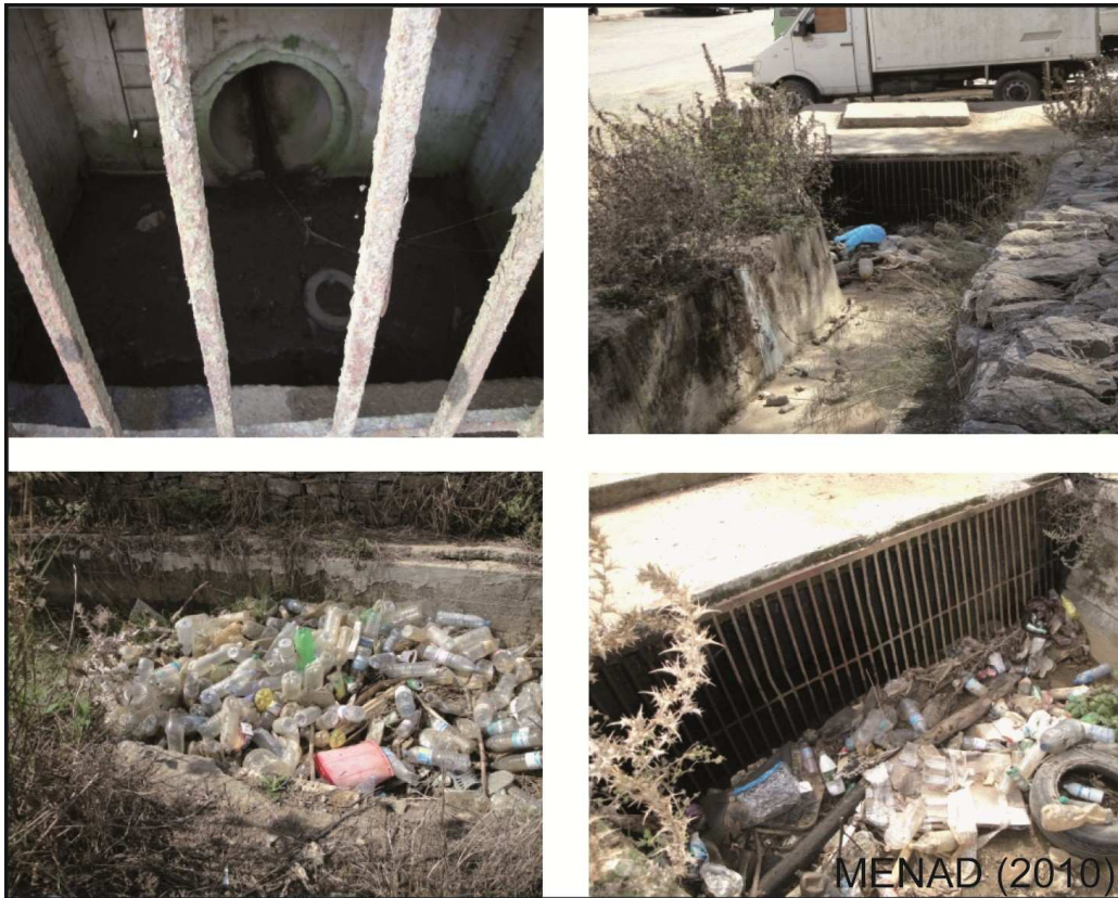
Fig. 7.3. Etat de l'ouvrage Baranes.
