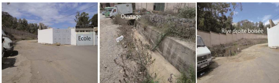
Fig. 7.19. Paysage autour de l'ouvrage hydraulique.
