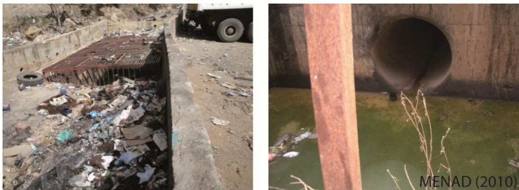
Fig. 7.8. Ouvrage hydraulique de réception Jaubert.
