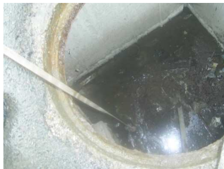
Mesures des taux d'encrassement dans les regards.
