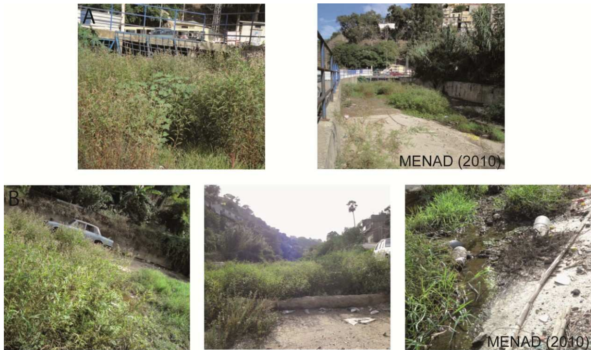
Fig. 7.5. Sidi Medjber : (A) Ouvrage de réception ; (B) Canal à ciel ouvert.
