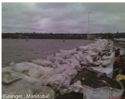
Fig. 8.9. Dispositifs de protection : batardeaux, sacs de sables.
