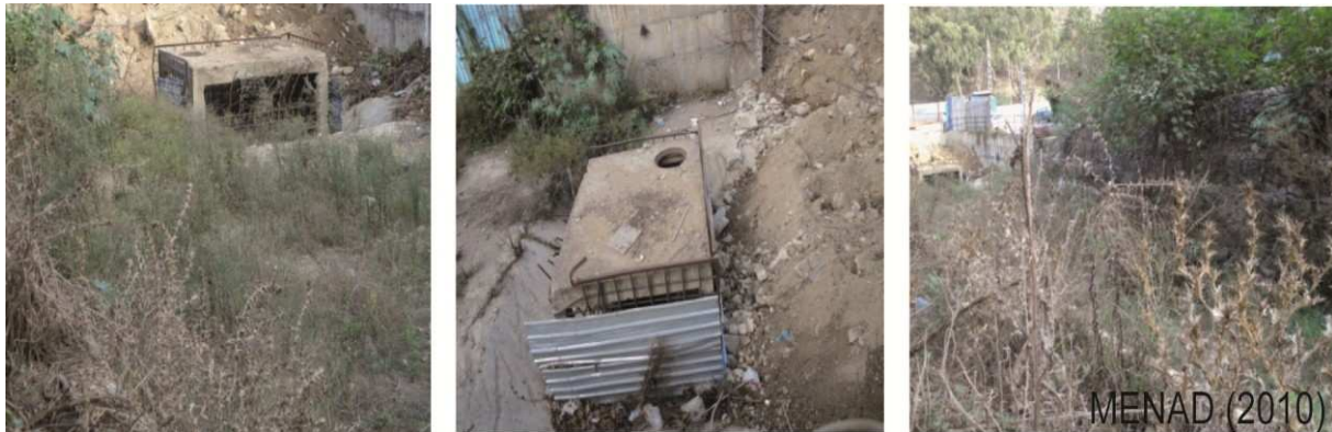
Fig. 7.6. Ouvrage hydraulique de réception de Frais Vallon
