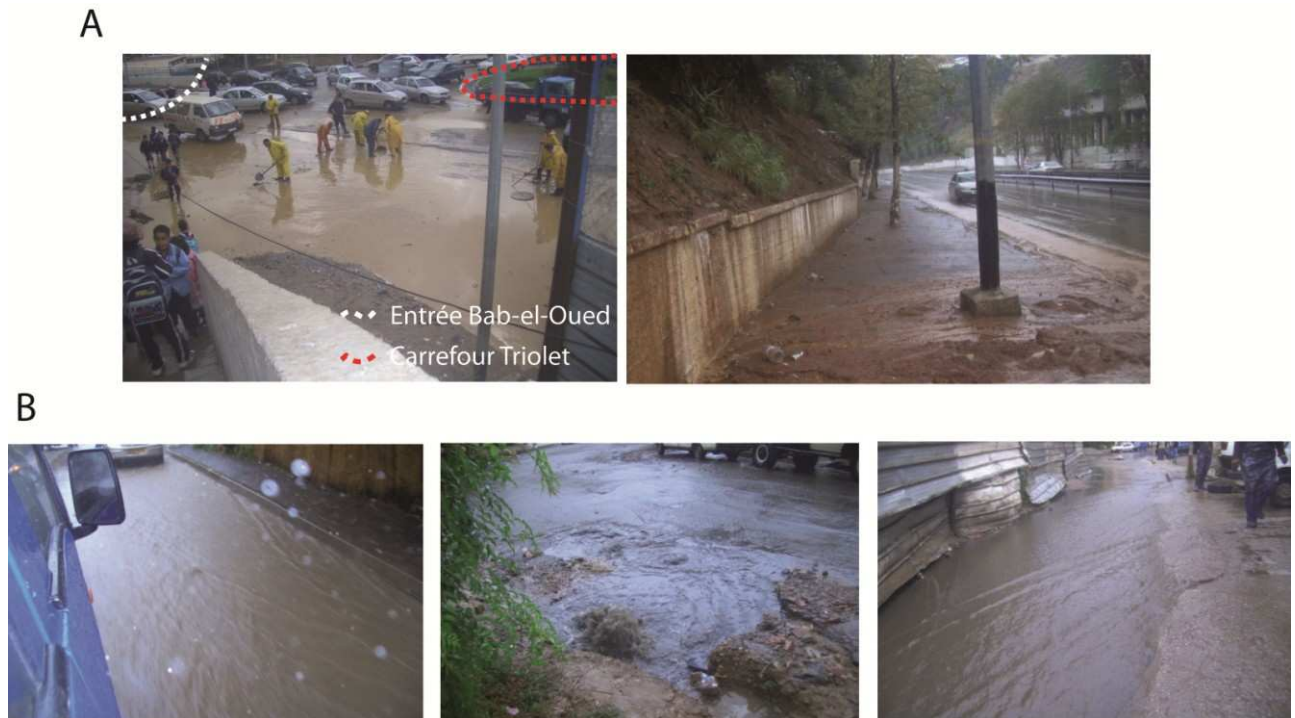
Fig. 7.34. Comportement des eaux pluviales au niveau de la voie rapide (A) et du réseau routier secondaire (B).
