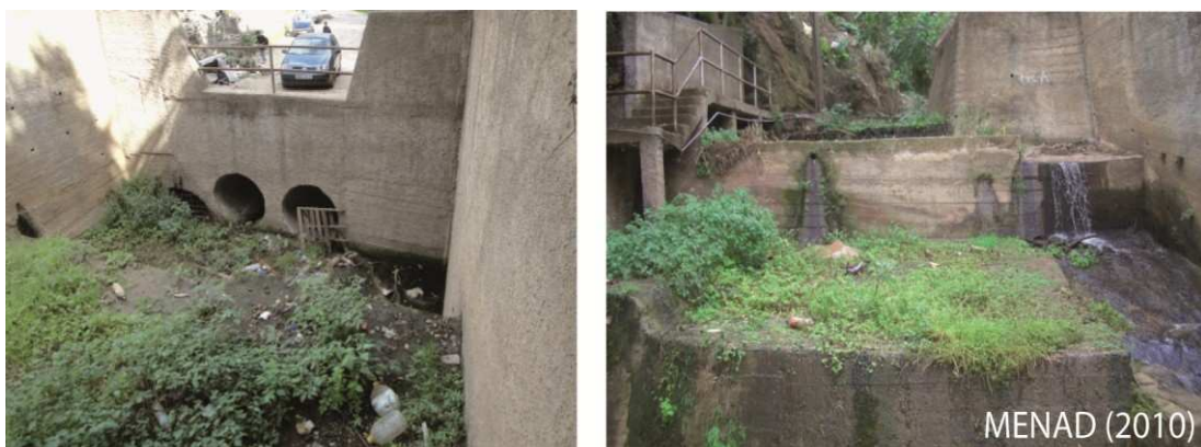
Fig. 7.11. Ouvrage hydraulique Chemin du Fort.
