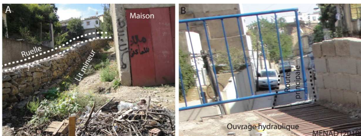
Fig. 7.25. Sous-bassin-versant de Scotto Nadal (A). Entrée amont de l'ouvrage hydraulique (B). Paysage en aval de l'ouvrage.
