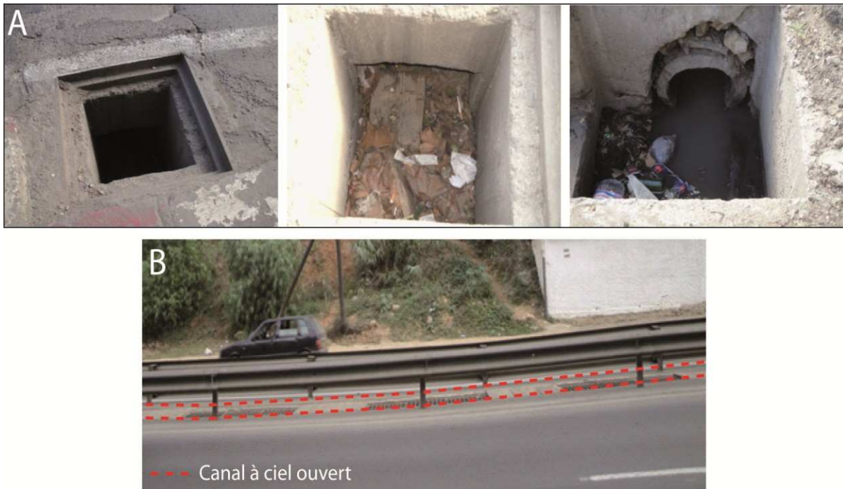
Fig. 7.33. Système d'évacuation des ruissellements de surface à partir de la voie rapide Chevalet-Triolet (A). Les avaloirs (B). Le canal à ciel ouvert.
