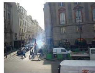
3- Travaux quai de Seine (Rive gauche)
