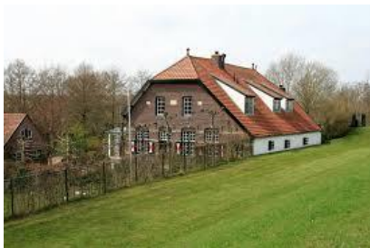
Photo 63 : exemple de dijkwoning ou « maison de digue ». Une partie de la maison est enfoncée dans la digue. Mais l'ensemble des réseaux électriques et de canalisation sont indépendants de la digue.
