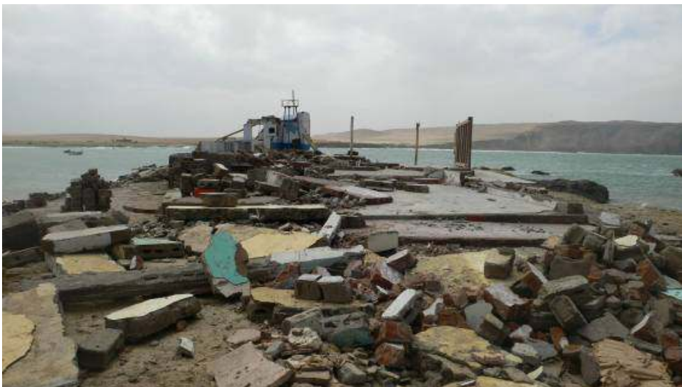
Photo 2 - Destruction par le tsunami d'un site touristique de la pointe de la baie de Lagunillas
