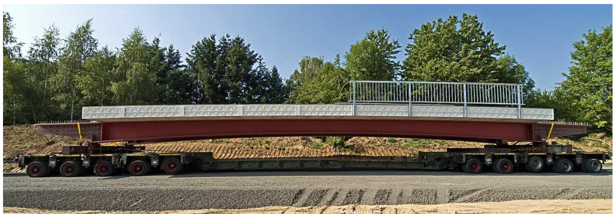
Abb. 2.14: Verkehrsbrücke aus GFRK-Profilen mit Stahlträgern [ITK09]
