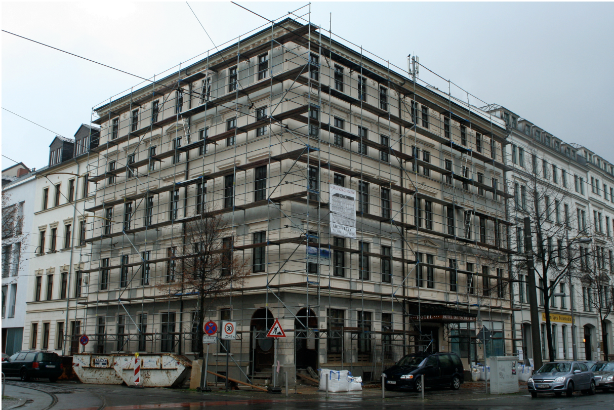
Abb. 11: Sanierung eines gründerzeitlichen Wohnhauses im Waldstraßenviertel (Quelle: Autor)
