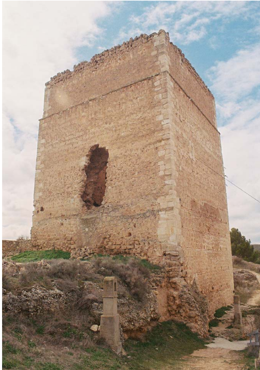
Figure 36. Tower. Arcos del Jalón.
