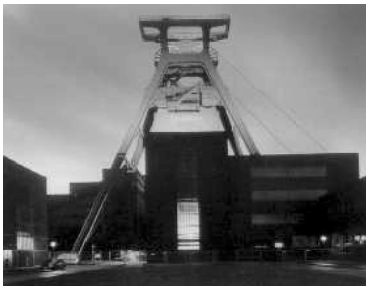
Abb. 5-8: Zollverein Schacht XII in Essen
