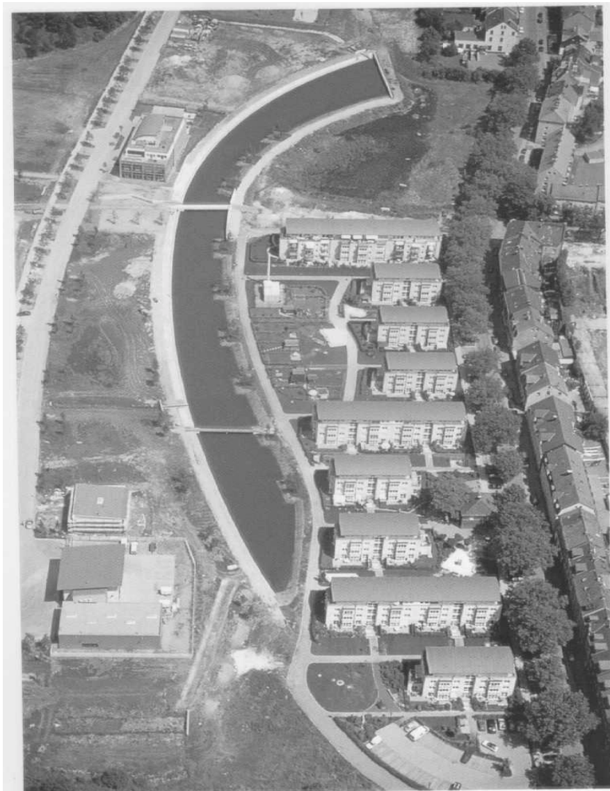
Abb. 5-14: Wohnbebauung und Regenwasseranlage in Bochum
