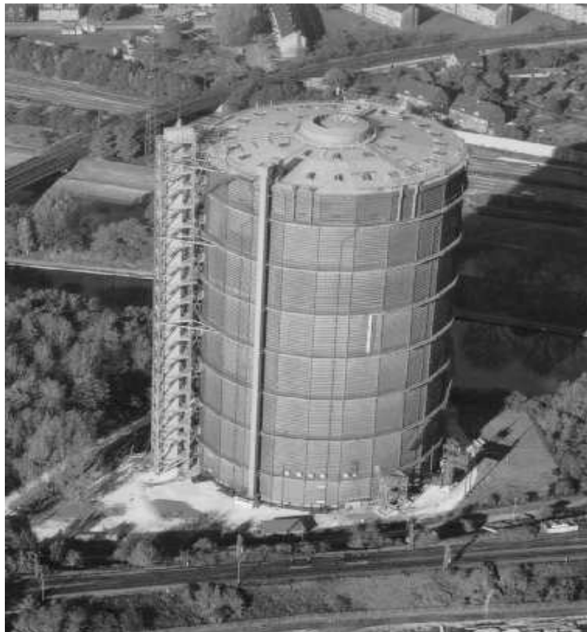
Abb. 5-7: der Gasometer in Oberhausen
