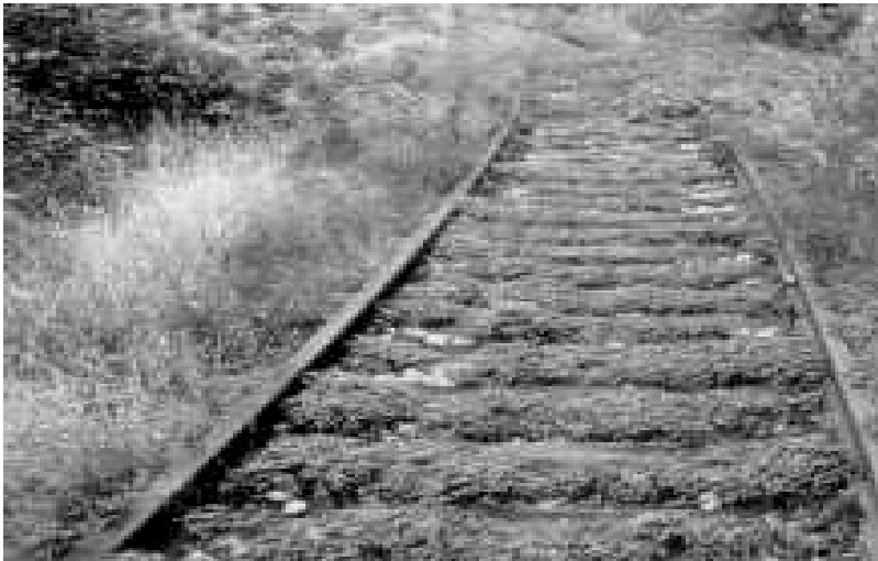
Abb. 5-17: Brachflächen in Emscherregion
