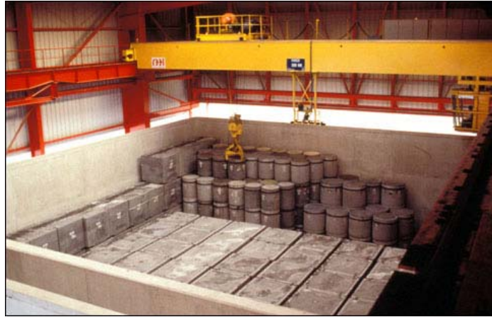
Image I-2. Remplissage d'un ouvrage en béton par des fûts de déchets FMA-VC au CSA [7].
