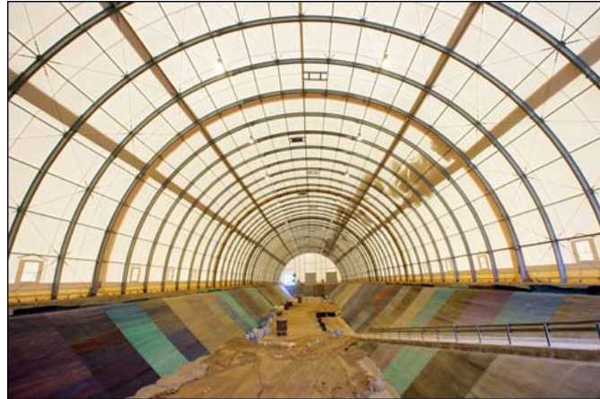
Image I-1. Vue intérieure d'une alvéole de stockage de déchets TFA au centre Cires à Morvilliers [6].
