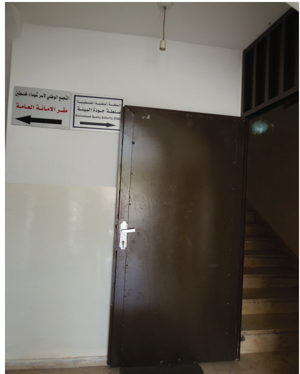
Photographie 5-Entrée du bâtiment de l'EQA.
