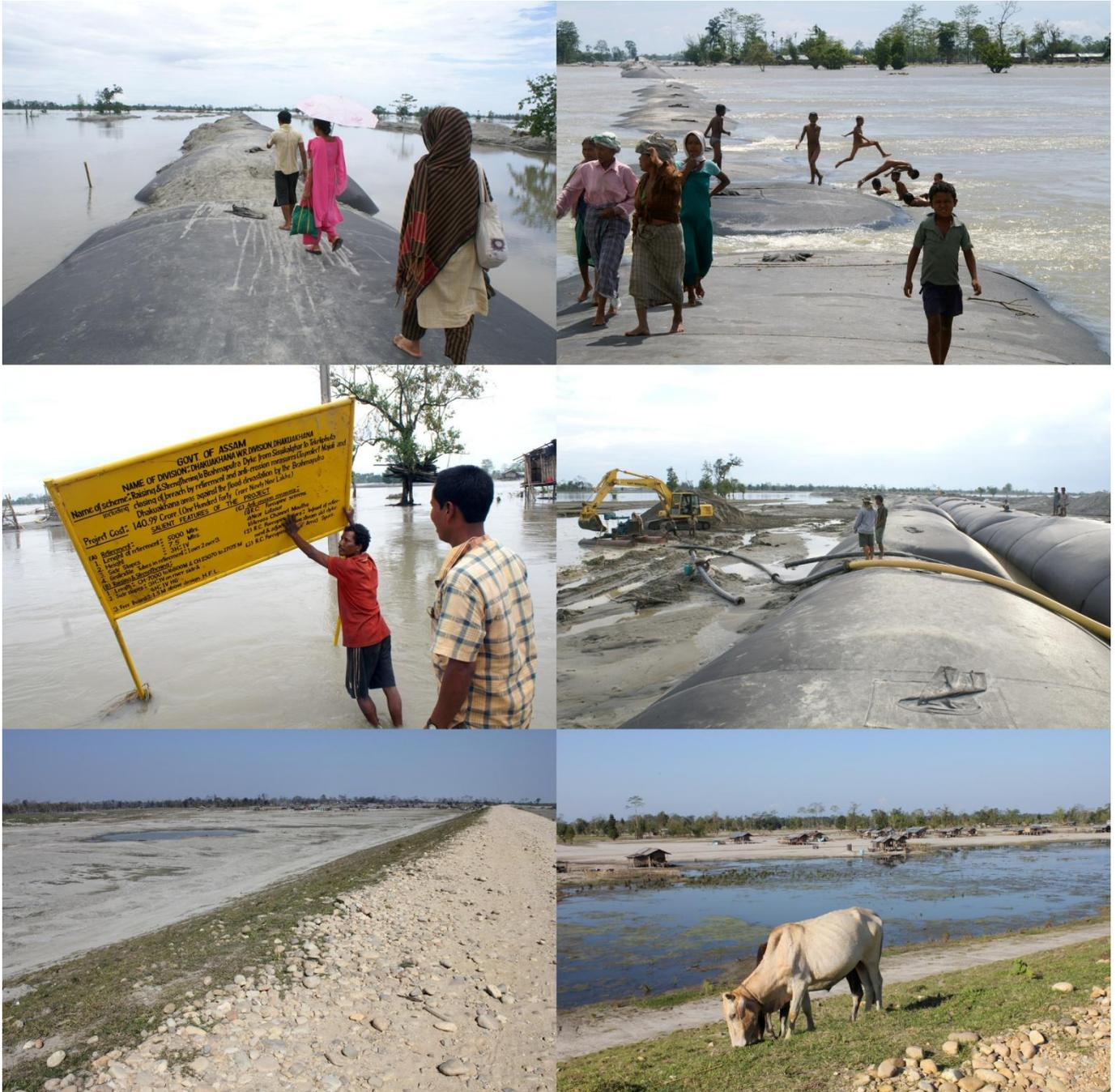
Planche photo 34 : Construction de la digue (Dhakuakhana). 1 et 2 - En 2009, la construction de digue a été interrompue par la crue du 1<sup>er</sup> juillet au 30 août ; 3 - Le panneau de présentation des caractéristiques de l'aménagement a été emporté par les flots ; 4- Les travaux ont repris après la décrue ; 5 et 6 - En janvier 2011, la digue construite et le village d'Ekoria Matmora pu se réinstaller en arrière.
