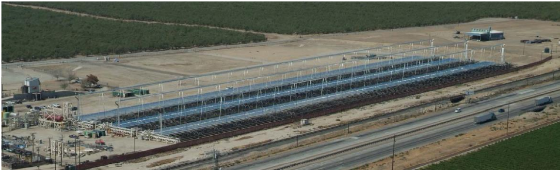
Figure I-16. Centrale de Kimberlina (Areva Solar)
