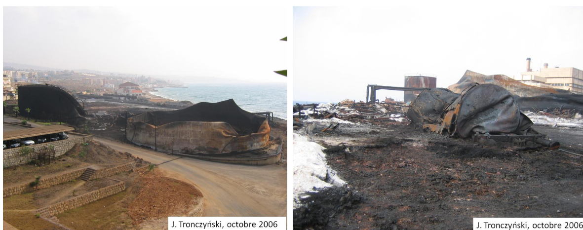
Figure 68 – État des cuves de la centrale de Jiyeh suite au bombardement en juillet 2006 ; ces photos montrent des cuves complètement vidées de leur contenu (à gauche) et les dégâts du feu et les cendres qui en ont résulté (à droite)
