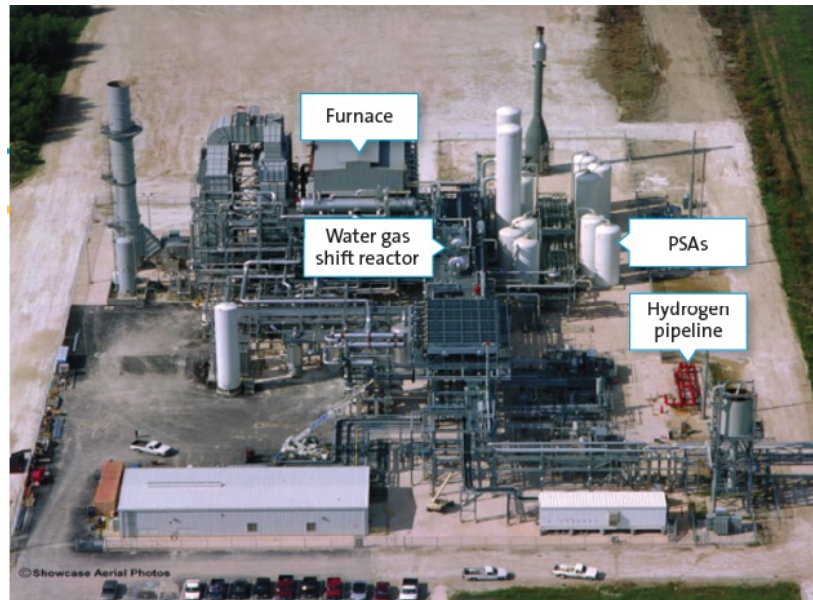
FIGURE 4 – Usine de production d’hydrogène par vaporeformage du gaz naturel
