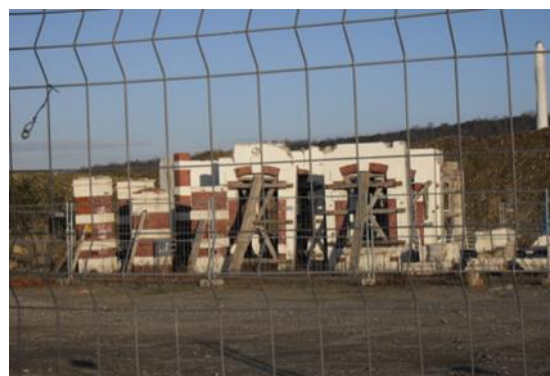
Photo 13 Mémorial en construction des anciens salariés d'AZF, Demoures, décembre 2008
