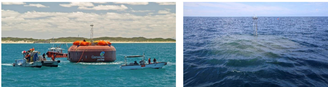
FIGURE 1.13 – Installation d'une unité CETO pour le projet Perth (Australie)
