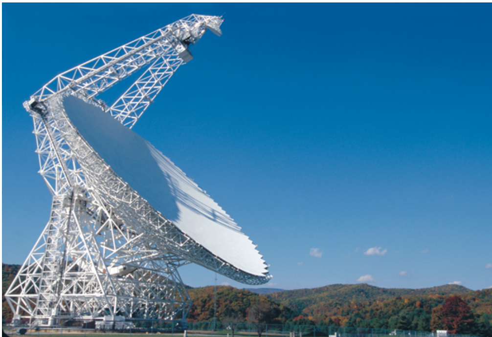
FIGURE 2.2 – Exemple d'antenne radio de grande taille : Green Bank Telescope en Virginie (USA), plus grande antenne mobile avec celle d'Effelsberg en Allemagne. (Image courtesy of NRAO/AUI)
