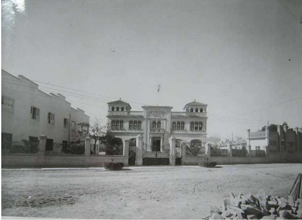
Vue de la façade du bâtiment de la section pour garçons de la Colonia San Vicente Ferrer (1947) 1000 .
