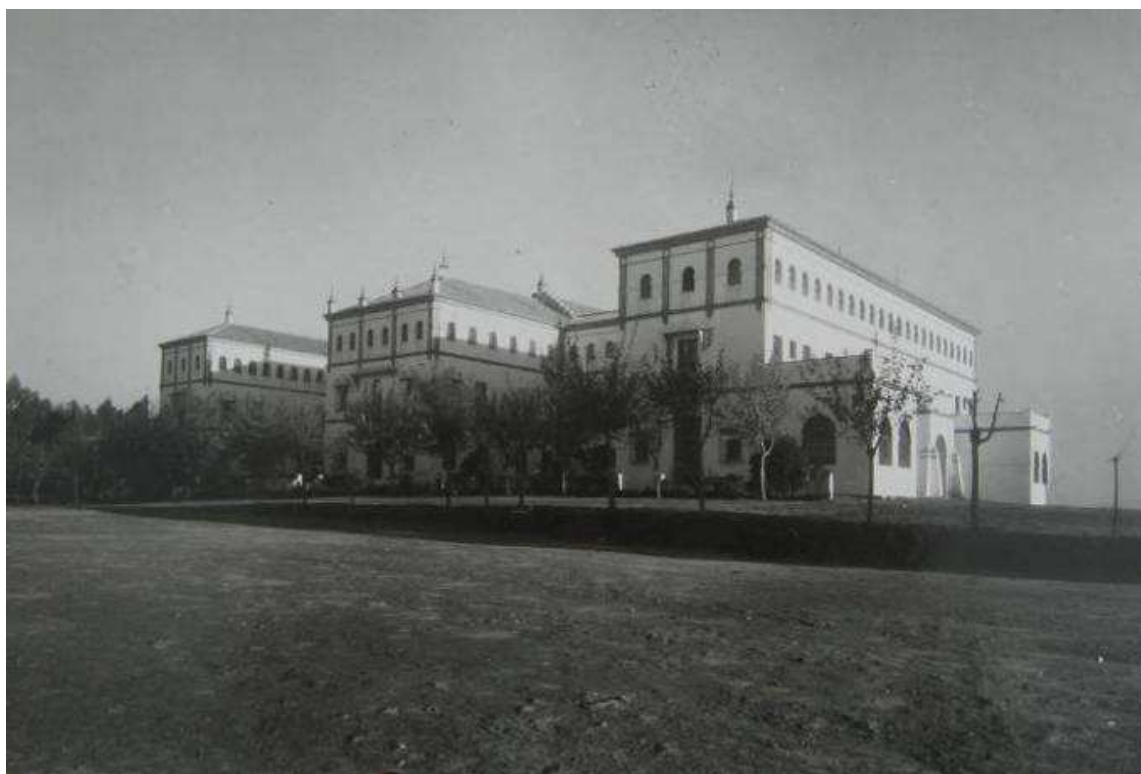
Vue générale de la maison de redressement San Francisco de Paula, construite à Alcalá de Guadaira, dans les environs de Séville (sans date) 190 .
