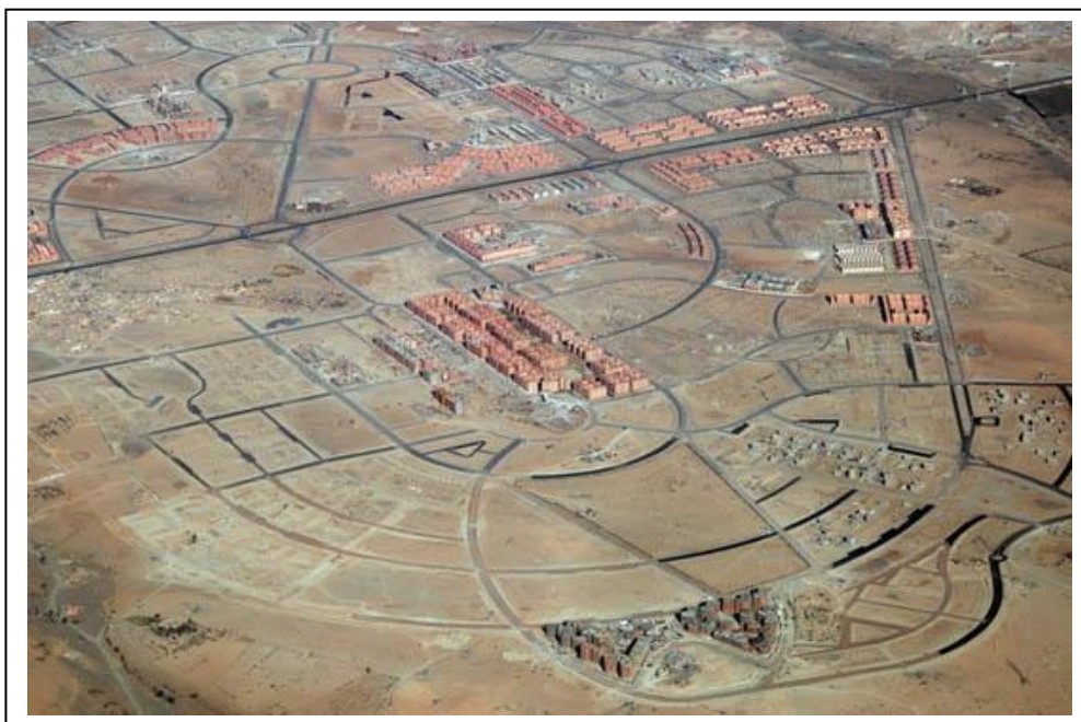
Figure 03. Ville nouvelle de Tamansourt en construction, à 10 km au nord de Marrakech (2010). Source : www.archi-mag.com .
