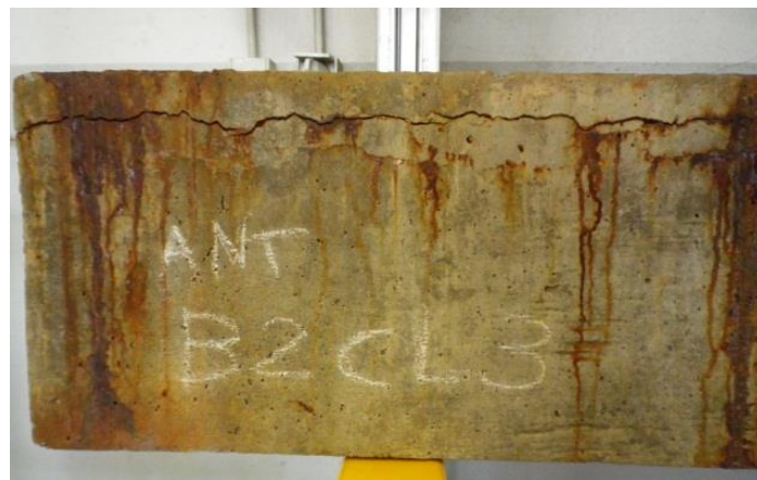
(b) Poutres corrodées B2Cl3 (28 ans)
