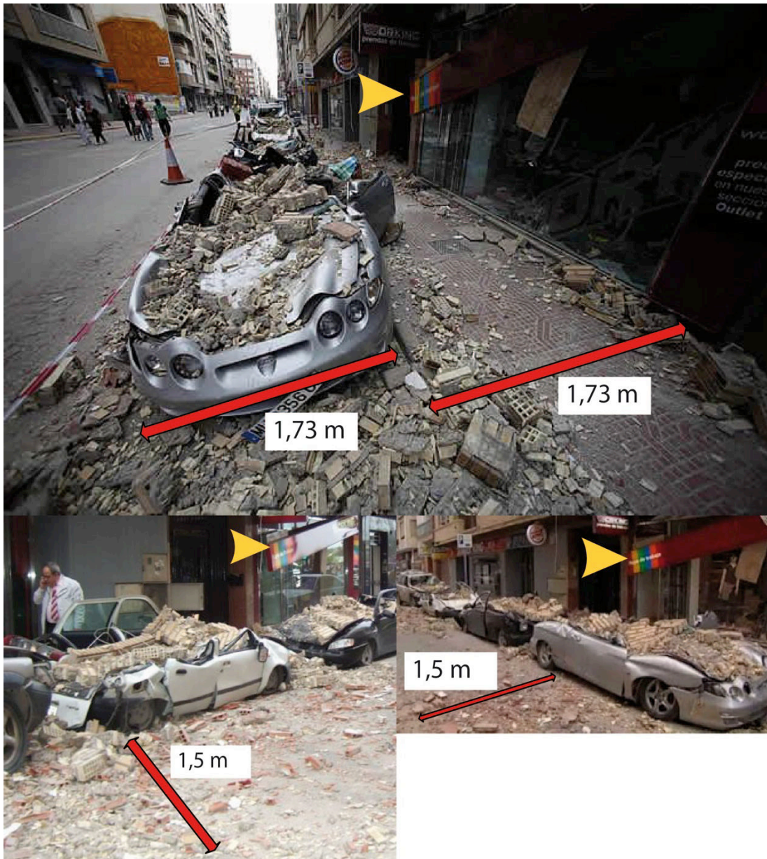
Figure 57. Exemple de mesure de la distance maximale d'impact. La flèche jaune nous donne un point de repère commun aux trois photos. Auteurs des photos : haut (REUTERS), gauche (La Verdad), droite (Luis Campoy).
