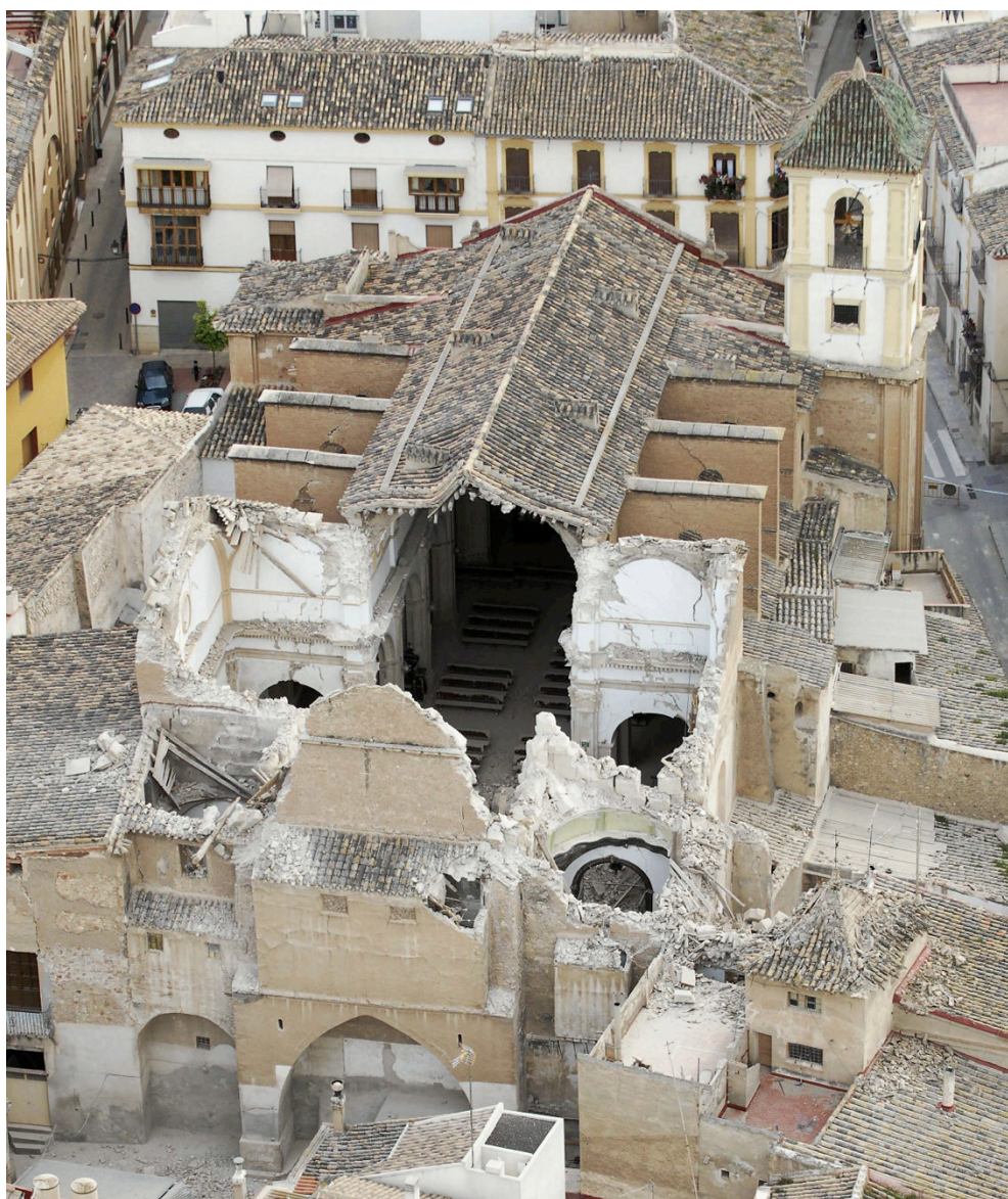
Figure 22. Vue aérienne de l'église de Santiago après le séisme. Sous l'énorme trou, le prêtre allait réaliser la séance de catéchisme annulée à la suite de la première secousse. Auteur : Nacho García.
