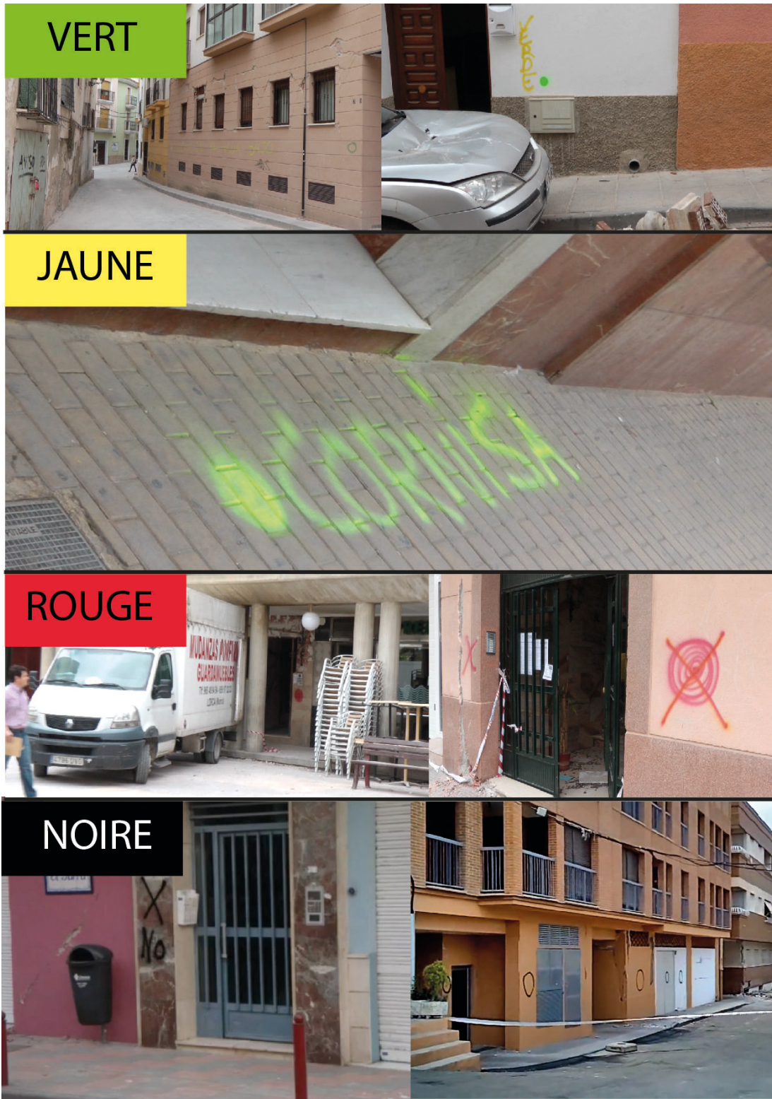
Figure 26. Exemple d'étiquetage vert, jaune, rouge et noir sur les bâtiments de Lorca. Pour l'exemple du bâtiment en jaune, il est aussi indiqué que la corniche est en équilibre et peut tomber. Auteur : Marc Bertran Rojo
