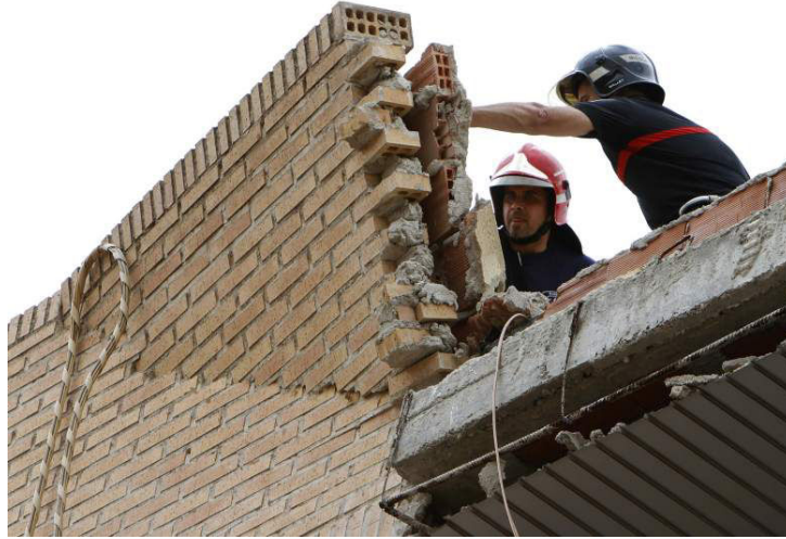
Figure 50. Pompiers faisant tomber de manière contrôlée une corniche en équilibre le lendemain du tremblement de terre de Lorca. Auteur : REUTERS.
