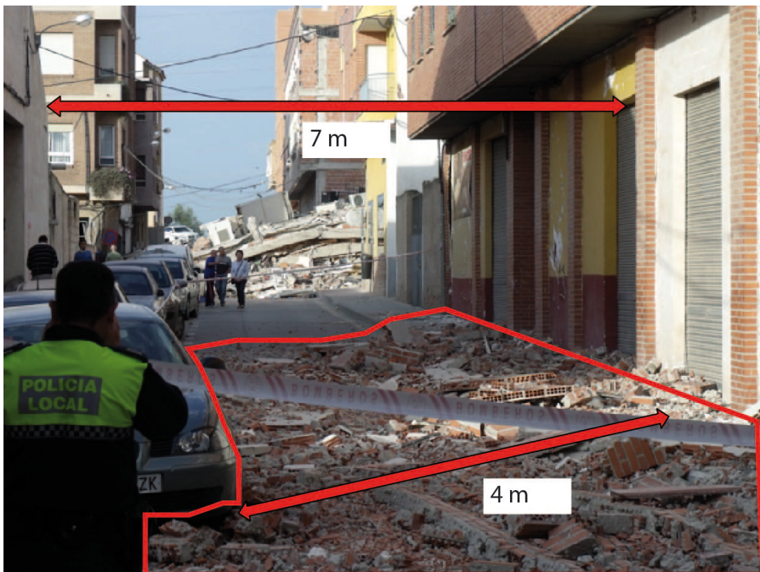
Figure 58. Exemple du calcul de la distance maximale d'impact. Auteur de la photo : La Verdad.
