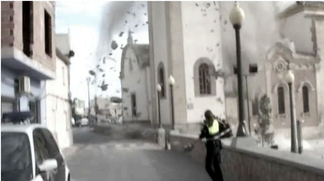
Figure 25. Chute en direct du niveau supérieur d'un clocher pendant une émission télévisée. Une importante quantité de débris sont propulsés sur la voie publique. Source : TheAnthonyo92 .noticias .
