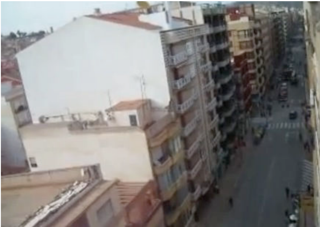
Figure 75. Vue de l'avenue Juan Carlos I deux jours après la secousse depuis un de ses bâtiments. Image extraite d'une vidéo d'un habitant de Lorca. Auteur: Carlos Segura.
