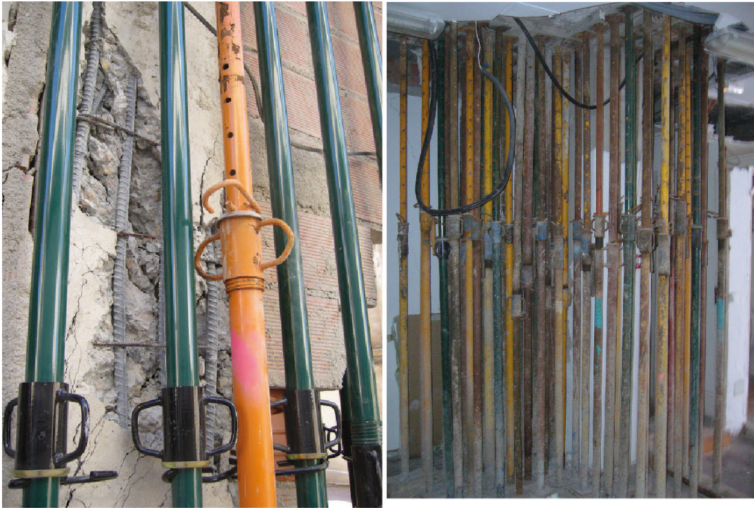
Figure 45. Exemples de réparations avec étais. Auteur des photos : Adrian Thomas Alarcon.
