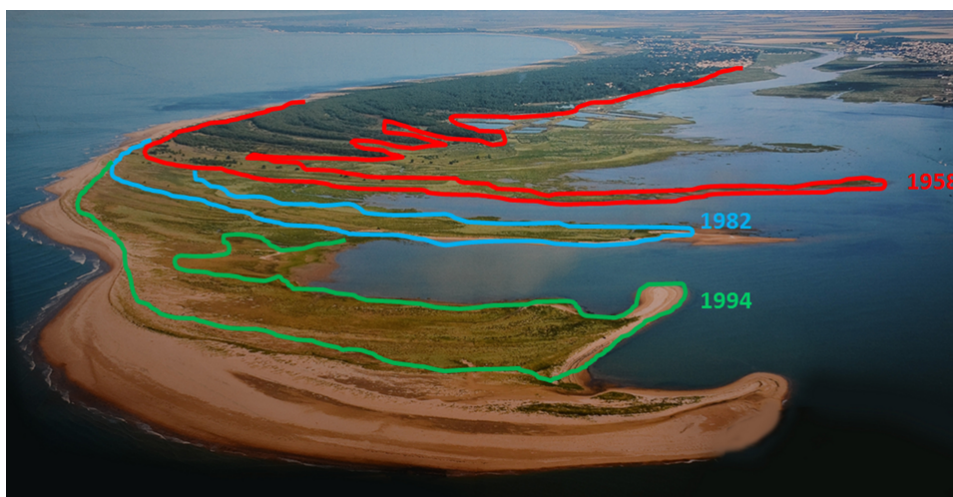
FIGURE 3.2 – Image aérienne oblique de la Pointe d'Arçay en novembre 2012 et position du trait de côte en 1958, 1982 et 1994, montrant que depuis six décennies, son développement alterne entre construction de crochets et progradation dans le sens de son allongement (Crédit J. Aubry).
