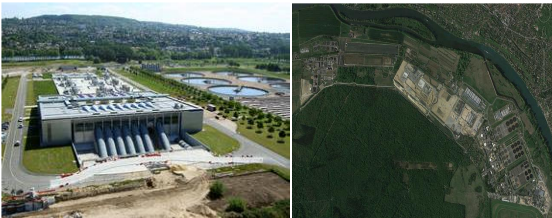
Figure 1-8 De gauche à droite : Vue aérienne de l'unité de traitement des pollutions phosphorées (Cliché SIAAP), Vue aérienne de la station d'épuration Seine Aval à 40 km en aval de Paris (photo aérienne, Google Earth 2015)
