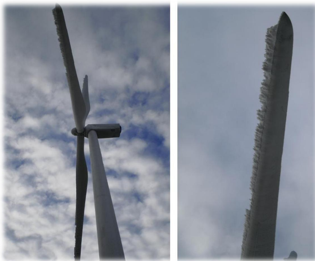
Figure 1.6 : Accumulation de givre sur le bord d'attaque
