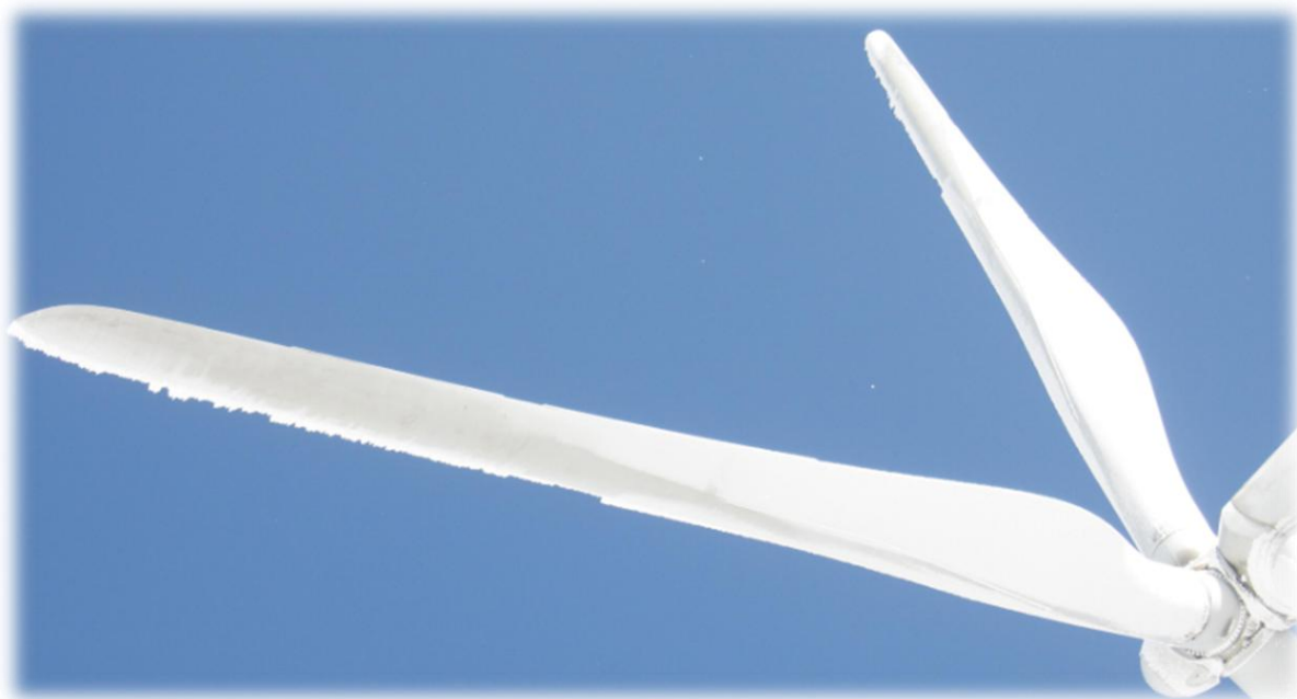
Figure 1.5 : Givrage de l'intrados et extrados
