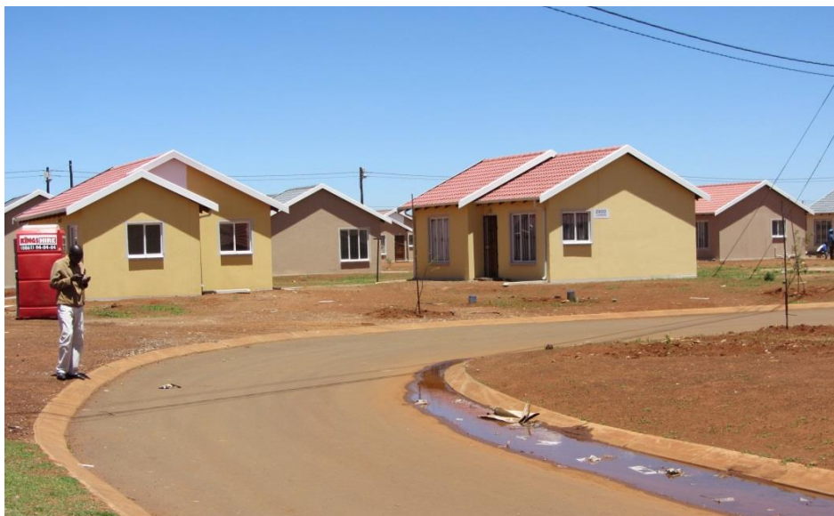
Figure n°2, source : auteur – extension 27, Protea Glen, cliché pris en janvier 2013.
