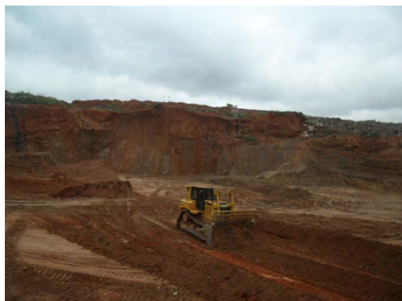
A. Aménagement d'une alvéole à la décharge de Nkol Foulou
