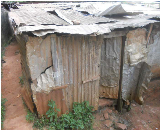
A : Salle de douche et latrine à Etam Bafia
