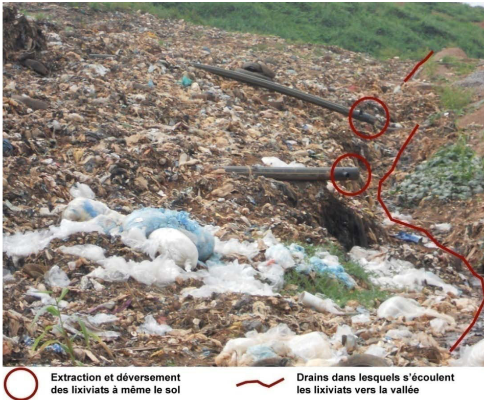
Photo 35 : Déversement des lixiviats à même le sol à la décharge de Nkol Foulou
