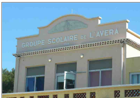
Figure 18 : Ancienne école de Lavéra, devenue aujourd'hui service de santé au travail (photo C.Osadtchy)
