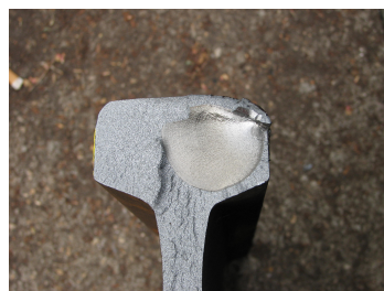
FIGURE 5.2 – Fissure interne ayant conduit à la rupture
