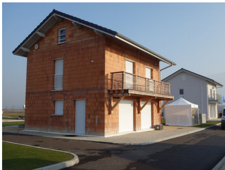
FIGURE 2.10 – INCAS-MA avant la pose d'enduit aérogel
