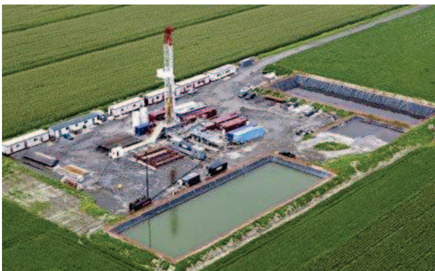
Figure 3 : Vue aérienne du forage de gaz de schiste de Saint-Barnabé Sud au Québec (source : François Roy, La Presse)
