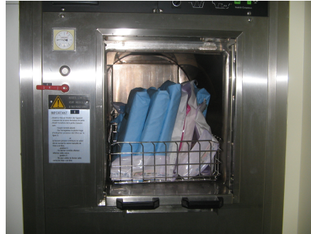
Figure 7.8: Charge de DM dans un autoclave
