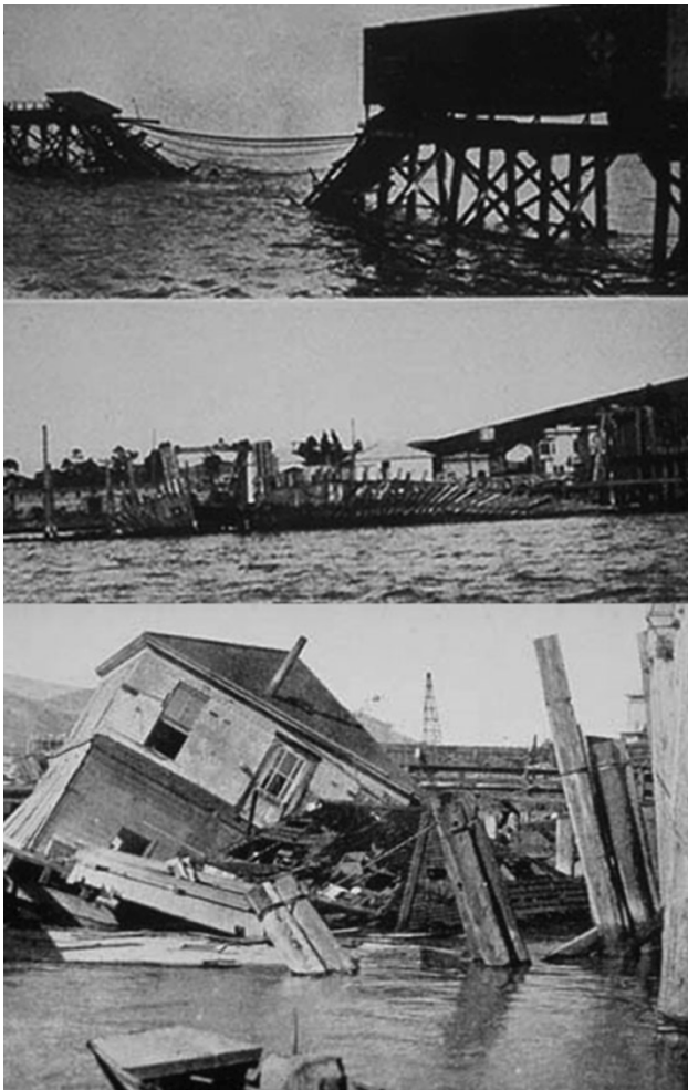
Figure 8 : Photographies anciennes dans la baie de San Francisco, de constructions détruites par Terredo Navalys . D'après Hill et al. , 1927
