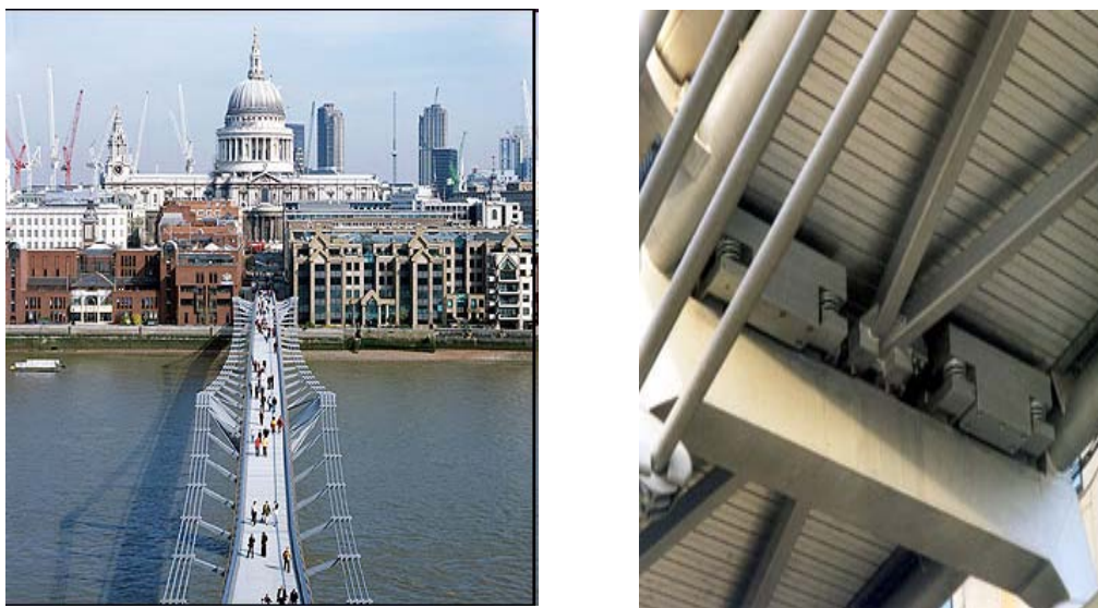
FIG.I. 9 -TMDs verticaux installés sous le tablier de la passerelle du Millenium à Londres.
