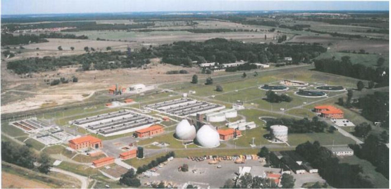
Photo 54 : La station modulaire de Gerwisch (à droite, les bassins extensibles)
