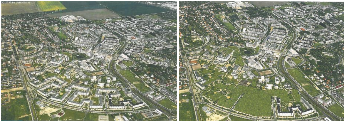
Photos 25 et 26 : La démolition de Rennebogen (quartier de Neu Olvenstedt)
