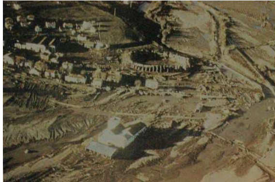
Photo II.5 Le quartier des arènes de Fréjus après le passage de la vague (Source : Donnât, 1990)
