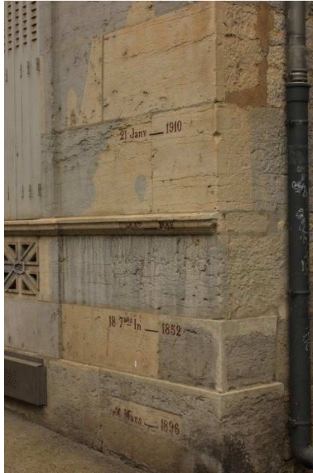
Photo VI.1 Marques de repères de crues dans le centre-ville de Besançon (Source : Photographie personnelle, mai 2014)
