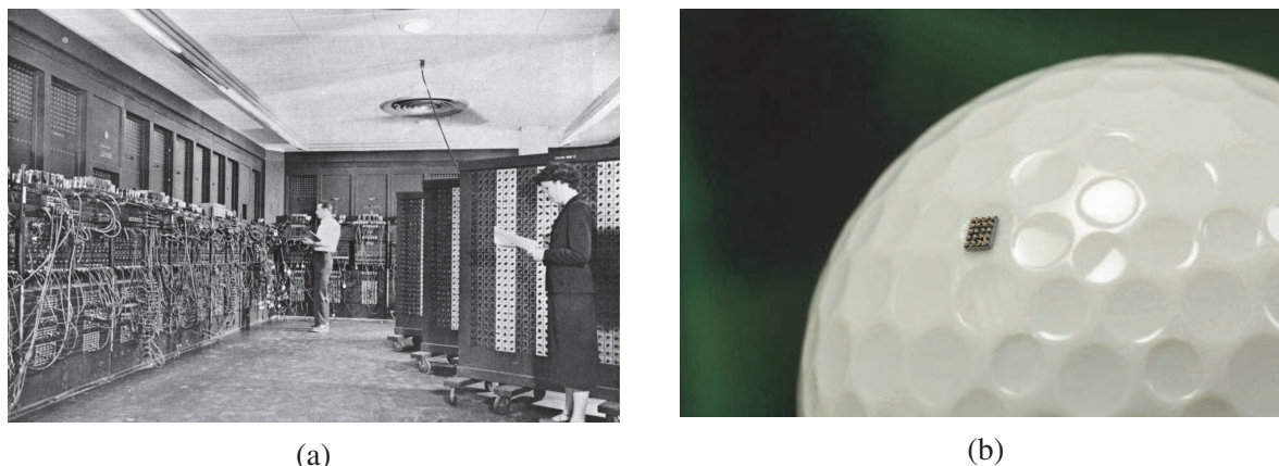
FIGURE 1.1: Photo de l'ENIAC, premier ordinateur électronique complet en 1946 (source : Wikimedia) (a) et le Kinetis KL03 de Freescale, le microcontrôleur ARM le plus petit du monde (2014), posé sur une balle de golf (source : www.silicon.fr ) (b). Le microcontrôleur est 50 000 fois plus petit mais 400 000 fois plus performant que l'ENIAC.
