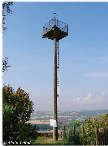
FIGURE I.3 – Phare aéronautique de Montferrand construit en 1927
