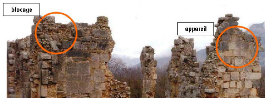
Fig. I.3 Les deux grands types de maçonnerie, Oikonomopoulou (2009)
