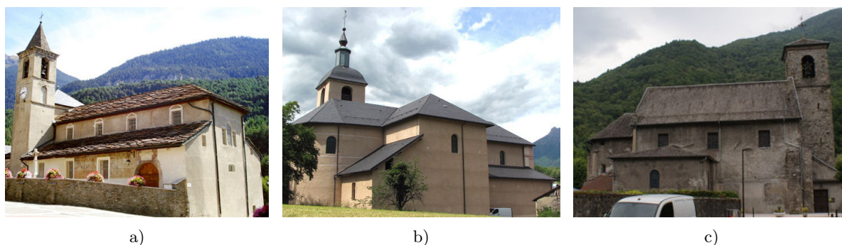
Fig. II.24 Type de plans. a) Saint-Thomas-Beckett, Avrieux : plan rectangulaire. b) Saint-Pierre, Coise-Saint-Jean-Pied-Gauthier : plan en croix latine d'origine, homogène. c) Saint-Etienne, Aiguebelle : plan en croix latine par adjonction de chapelles latérales au XVIIIe.
