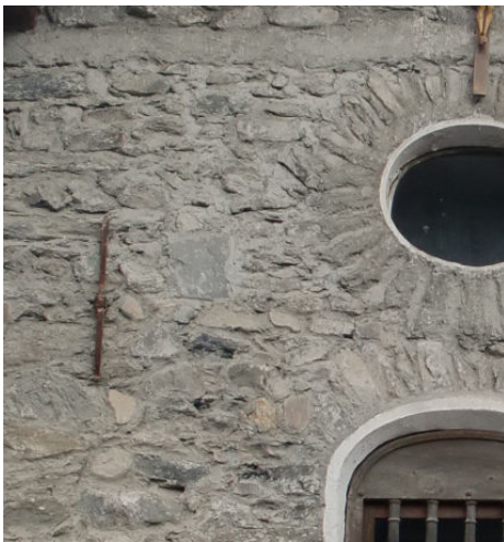
Fig. I.2 Chapelle Saintes Agathe et Apollonie, Petit-Gondon, Bourg Saint Maurice : maçonnerie à base de galets.
