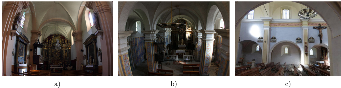
Fig. II.26 Nombre et forme des nefs. a) Saint-Martin de Tours, Rognaix : nef unique. b) Saint-Pierre, Nâve-Fontaine, La Léchère : église-halle. c) Saint-Georges, Saint-Georges des Hurtières : collatéraux boutants et fenêtres hautes.
