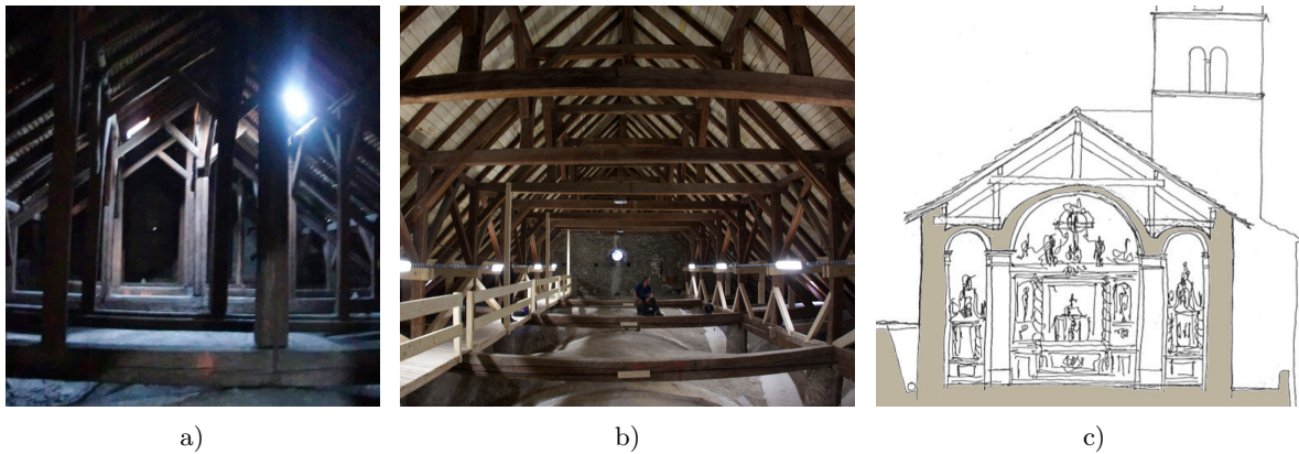
Fig. II.15 Charpentes à poteaux. a) Saint-Grat, Conflans, Albertville : gitte sans support intermédiaire. b) Saint-Gervais Saint-Protais Saint-Gervais-las-Bains : gitte reposant sur les piliers de la nef, poteau du milieu tronqué par deux faux-entraits. c) Saint-Pierre, Villard-sur-Doron : adaptation pour passer la voûte de la nef.
