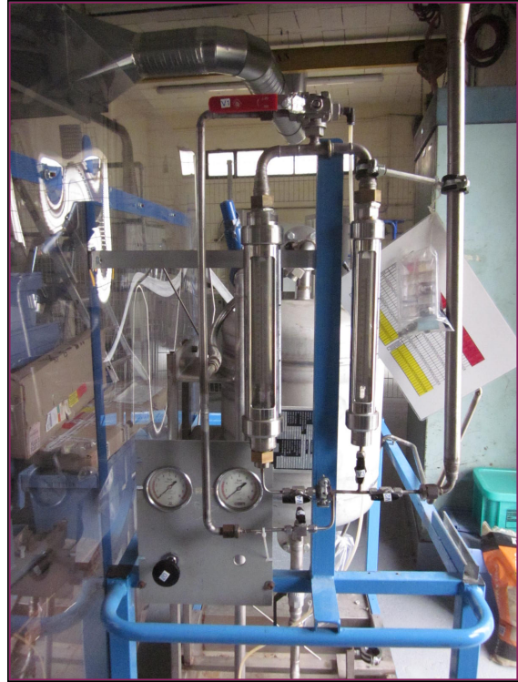
FIGURE 3.3 – Le skid blizzard . Au premier plan, les deux doseurs.
