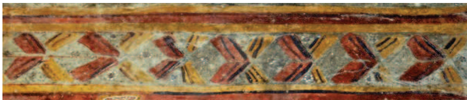
Illustration 116 : Tracés au cordeau visibles sur les frises.
