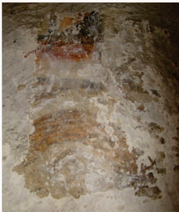
Fig. 53 : Élément figuratif en partie supérieure du mur gouttereau sud. Tour sud ouest. Abbayes Sainte-Marie d'Arles-sur-Tech. Cliché Anne Leturque.
