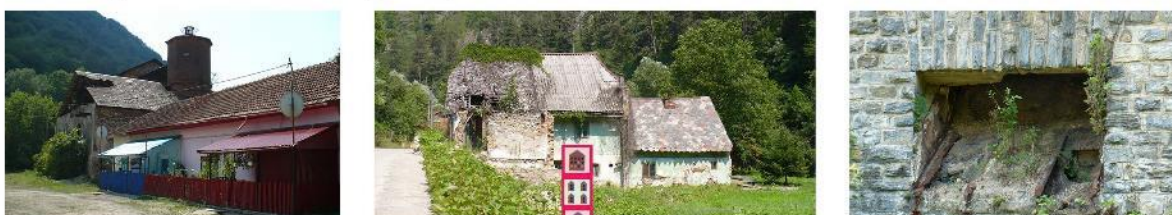
© 2013 Govăjdia. Maisons et dépendances du haut fourneau.
