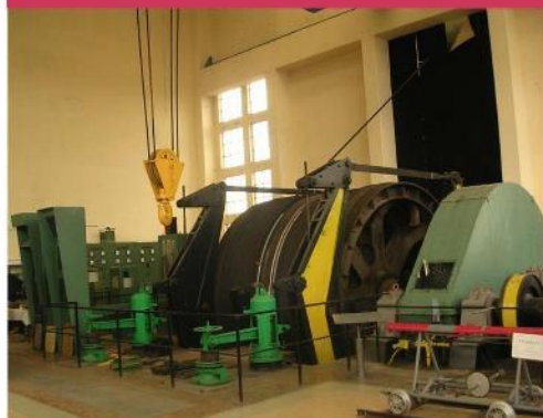
Salle de la machine d'extraction.
