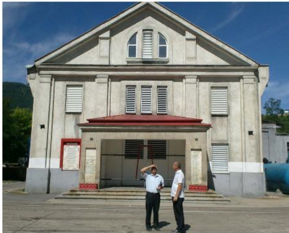
© 2013 Lupeni. Le transformateur électrique.
