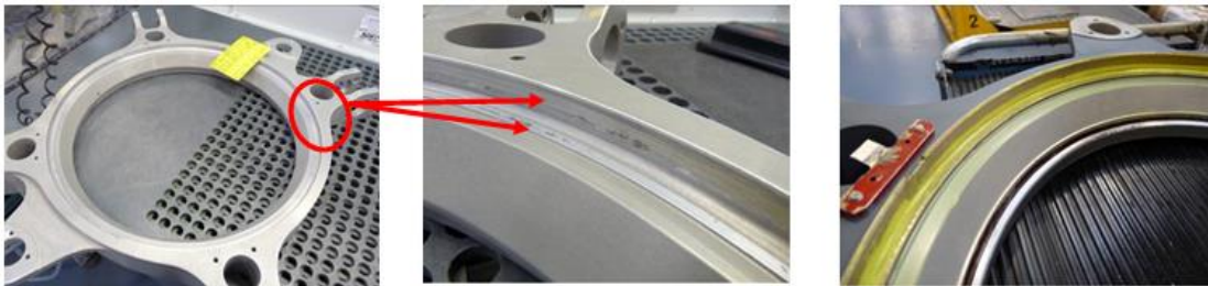
Figure 7-36 : Plateau cyclique en alliage d'aluminium avec la présence de traces de corrosion et de fretting (à gauche et au centre), à droite, réparation actuelle par frettage : ajout d'une bague en acier, cas 3 [CSA12].
