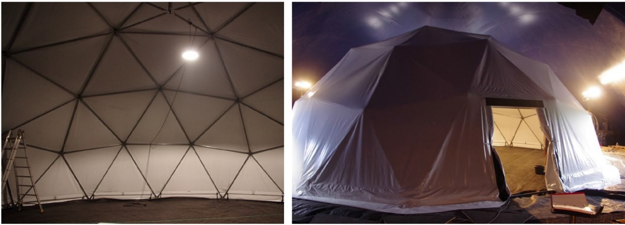
Figure 32 : Montage du dôme.
