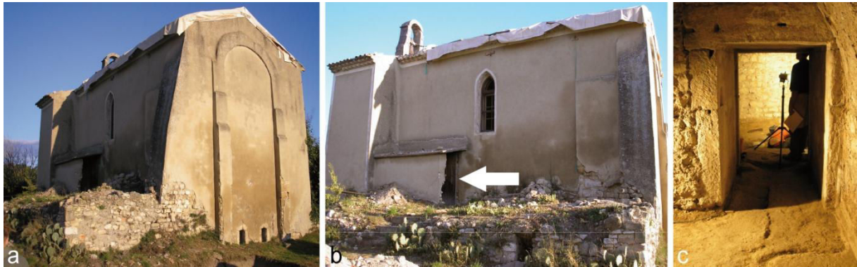
Figure 122 – Sainte-Tulle : vue du chevet de la chapelle (a), de la façade sud (b) et de l'entrée de la crypte (flèche blanche), et des seconde (premier plan) et troisième salles (second plan) de la crypte (c) en 2006 (clichés : R. Corbineau).
