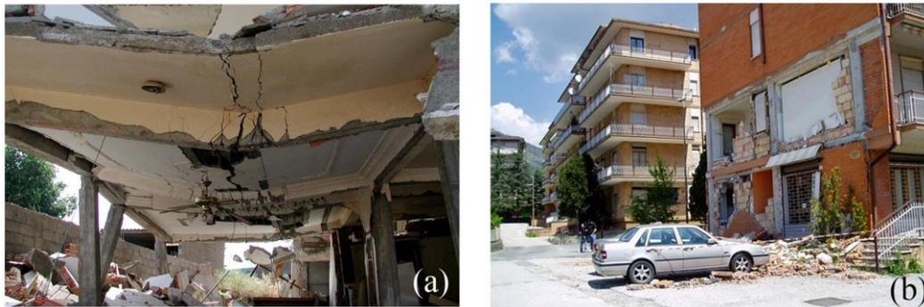
**Figure 1-8: Dommages divers (a) : Rupture par flexion des poutres ; (b) : Dégâts non structurels en façade (Séisme de L'Aquila 06/04/2009)**
